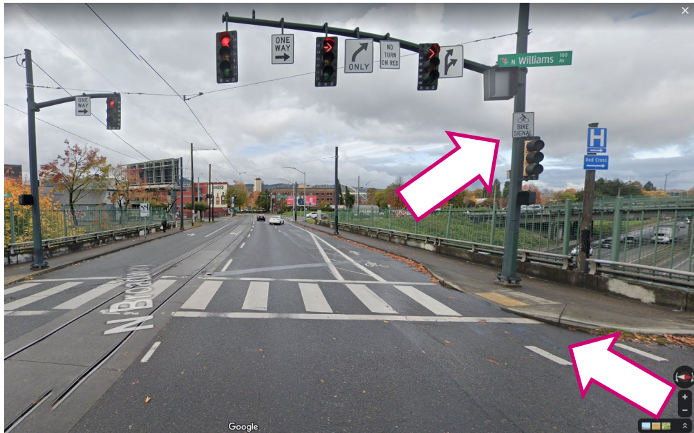
Figur 8: Broadway and Williams i Portland Oregon, USA. Ett cykelfält markeras över korsningen med den nedre infällda pilen och den övre pilen pekar ut en särskild ljussignal för cyklande. Det är dock förbud mot att svänga höger vid röd signal (för alla fordon). (Källa: Google, 2022).
