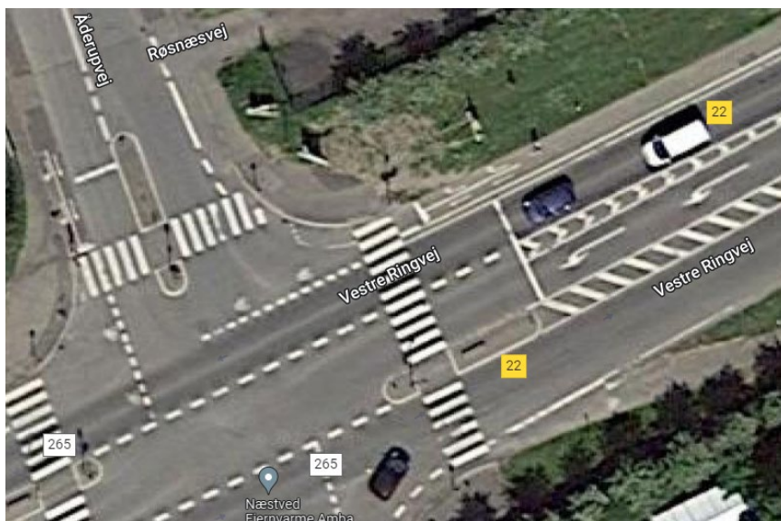
Figur 11: Vy från ovan över försökskorsningen Vestre Ringvej och Åderupvej i Næstved, Danmark. www.google.dk.maps april 2021.
