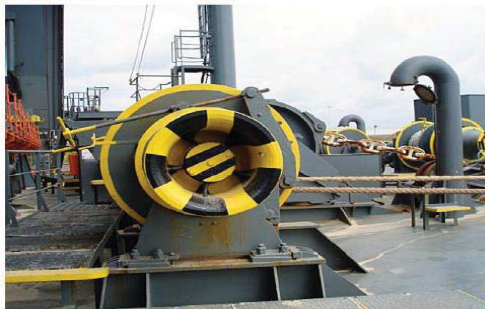
Vinsch med varningsmarkeringar
