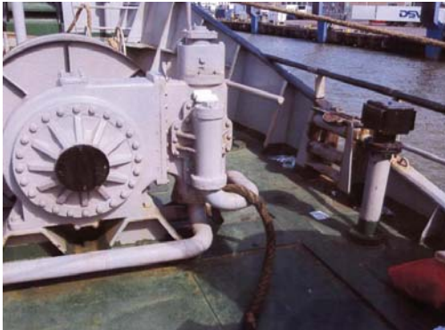
Förtöjningsplatsen sedd akterifrån efter olyckan
