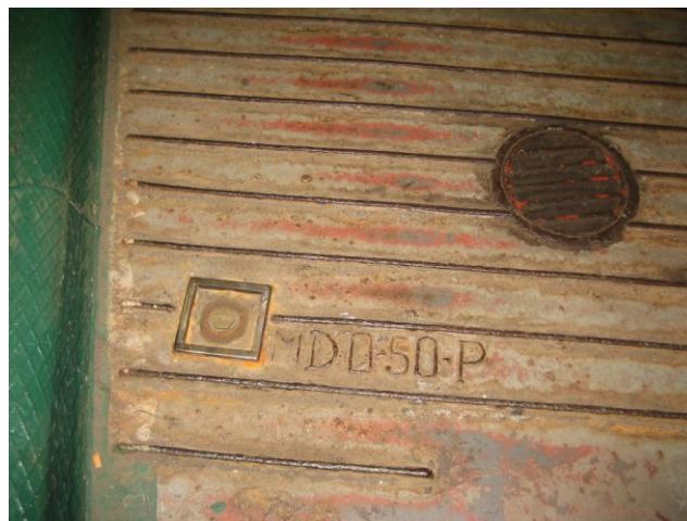
Den läckande pejlpluggen och scuppern intill
