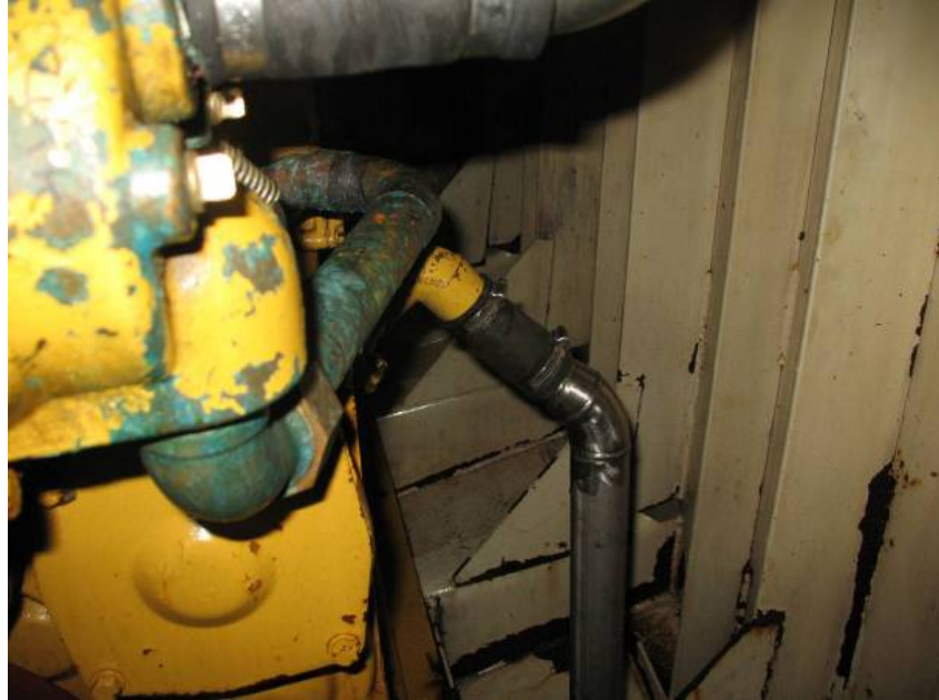
Kylvattenanslutningen som lossnade
