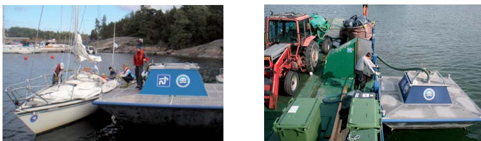
Figur 11. Flytande sugtömningsstation med handdriven tömningspump
