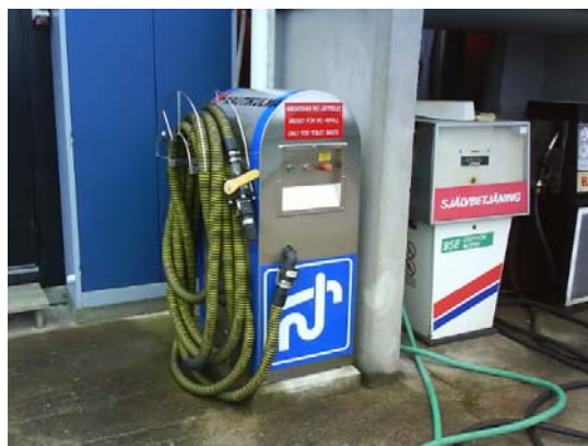
Figur 7. Exempel på bryggmonterad anläggning baserad på membranpumpsteknik
