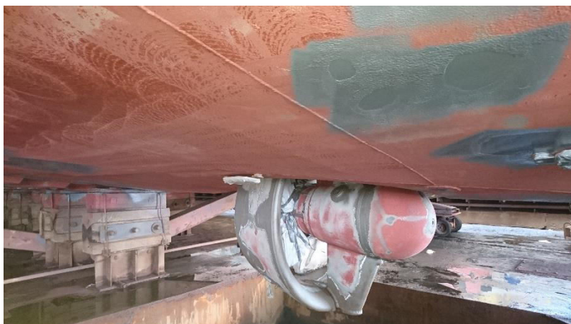
Figur 5. Bild från torrdocka på ett fartygsskrov med punktblästrade områden som övermålsats med primer (grå färg) innan övertäckning med ny bottenfärg på hela skrovet.
