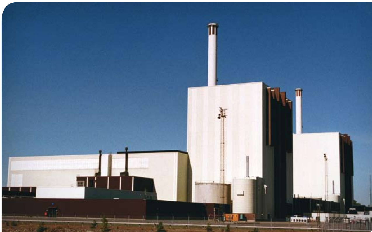
Forsmark kärnkraftverk, Vattenfall
