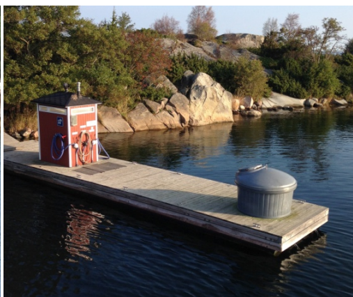
Figur 3. Sugtömningsstation i Norrtälje kommun, Rödlöga. I samband med tömning utfördes provtagning vid denna station.
