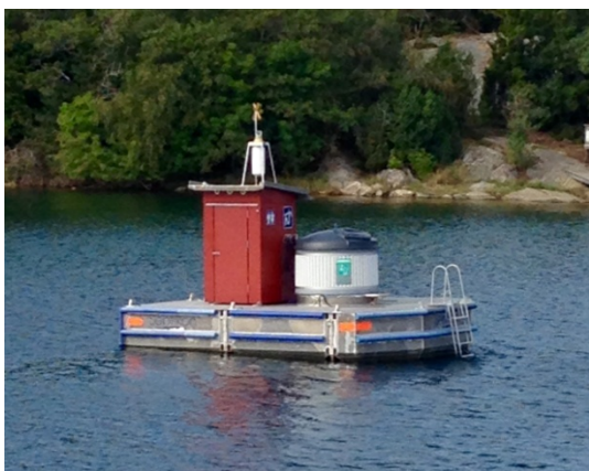
Figur 2. Sugtömningsstation i Norrtälje kommun, Arholma. I samband med tömning utfördes provtagning vid denna station.
