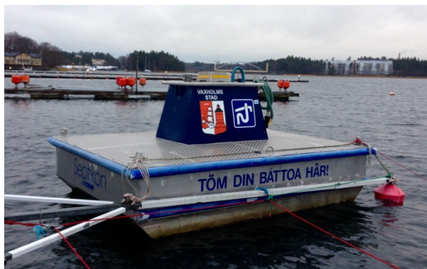
Figur 4. Sugtömningsstation i Vaxholm, Norra Vaxön. I samband med tömning utfördes provtagning vid denna station.
