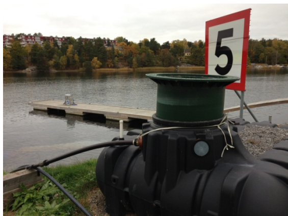
Figur 5. Sugtömningsstation i Värmdö, Farstaviken. I samband med tömning utfördes provtagning vid denna station. Tömningsanordningen ses på bryggan i bakgrunden och är kopplad till tanken i förgrunden.
